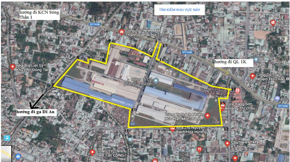
Vị trí của nhà máy sản xuất công ty Cổ phần Maruichi Sun Steel
