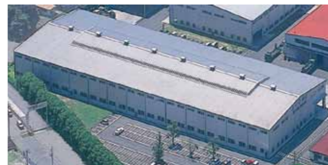
Mái nhà Roof
